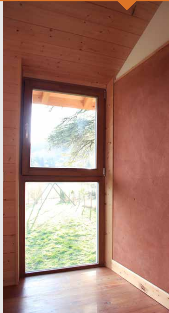
Les menuiseries viennent d'un fabricant local. La pièce de musique est équipée en triple vitrage.
