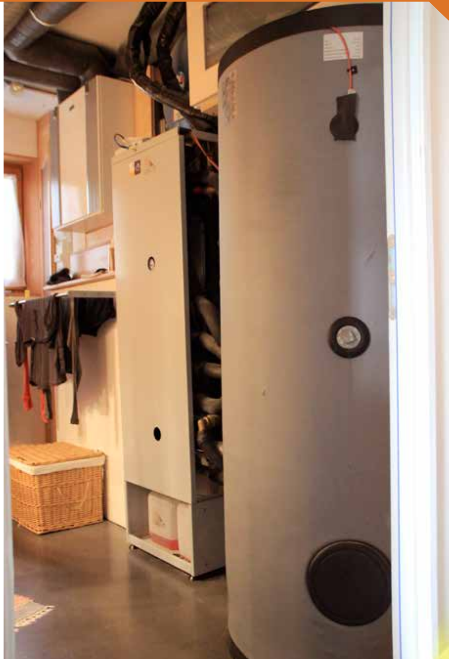
Le ballon de 400 litres et l'armoire des différents réseaux hydrauliques ont pris place dans le local technique à côté de la double flux.
