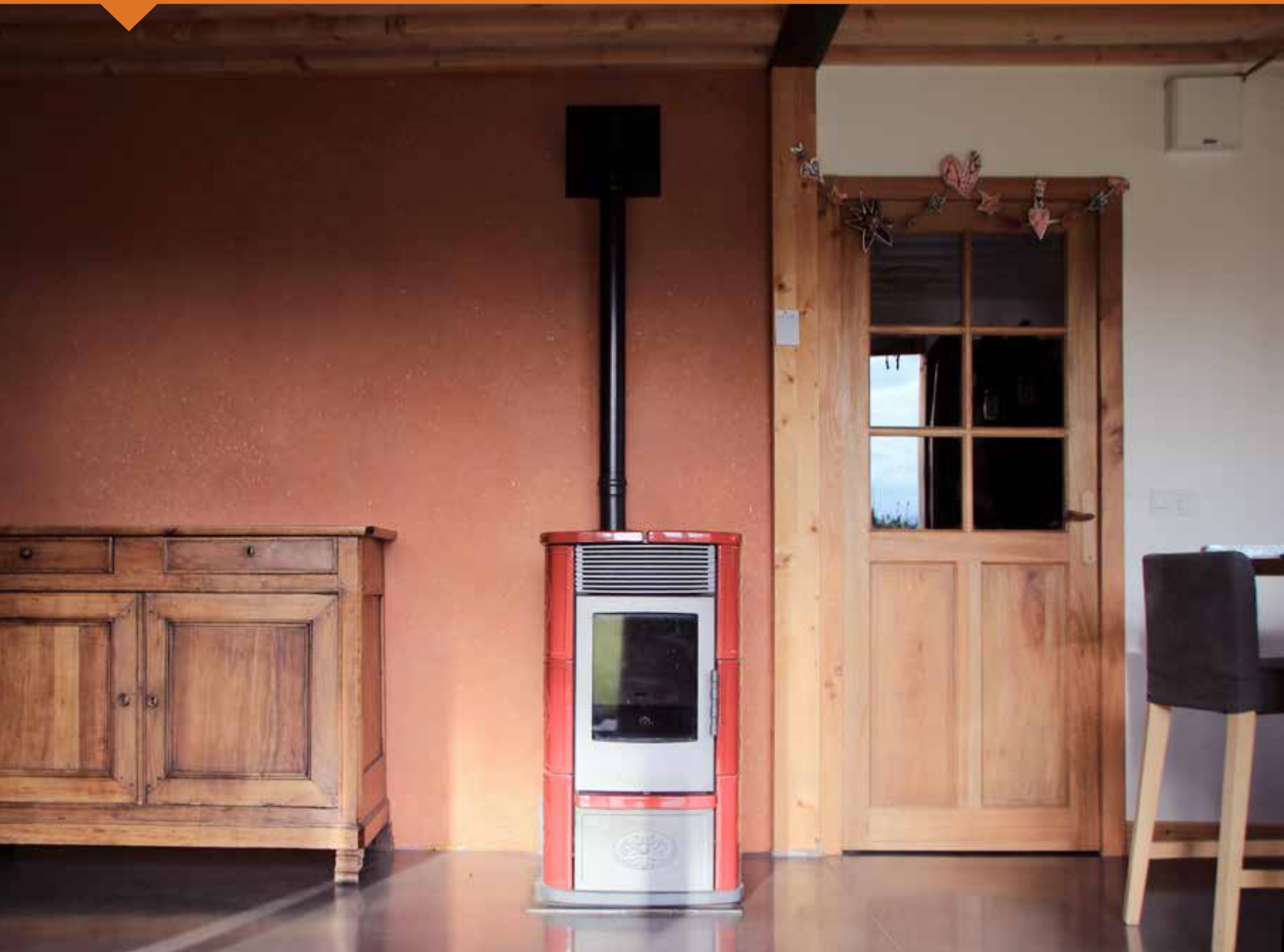
Seul appoint du solaire, le poêle à granulés hydro se déclenche automatiquement dès que c'est nécessaire.
