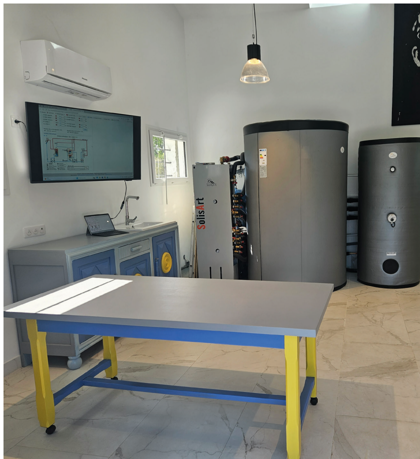
SoliConfort 2 (SC2) gère en complémentarité le ballon sanitaire et le ballon de stockage.
